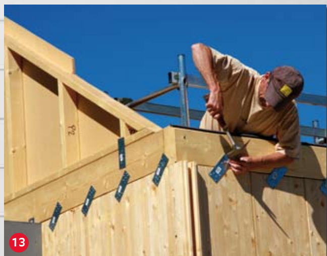
Pose de la lisse haute (avec plaques de fixation), sur laquelle les éléments de la toiture vont venir s'appuyer. Les panneaux massifs en toiture (pignons et porteurs) sont triangulaires et toujours manu-portables. Ils sont moins hauts que les panneaux muraux (2,50 m contre 3,40 m) et donc, plus légers (40 kg).
