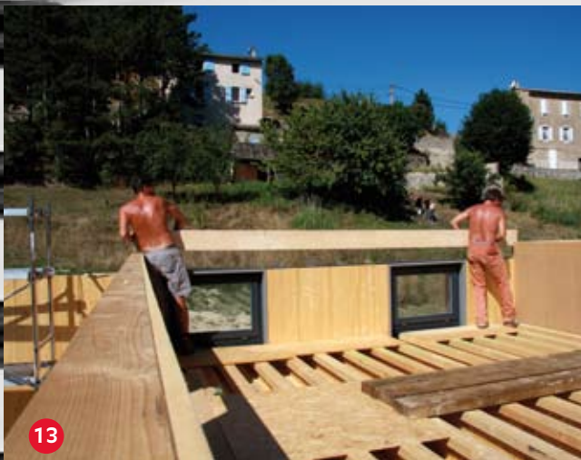
Pose de la lisse haute (avec plaques de fixation), sur laquelle les éléments de la toiture vont venir s'appuyer. Les panneaux massifs en toiture (pignons et porteurs) sont triangulaires et toujours manu-portables. Ils sont moins hauts que les panneaux muraux (2,50 m contre 3,40 m) et donc, plus légers (40 kg).
