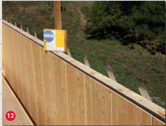
Phase importante, la pose du compriband (fourni dans le kit), qui assure l'étanchéité à l'air entre les différents éléments.
