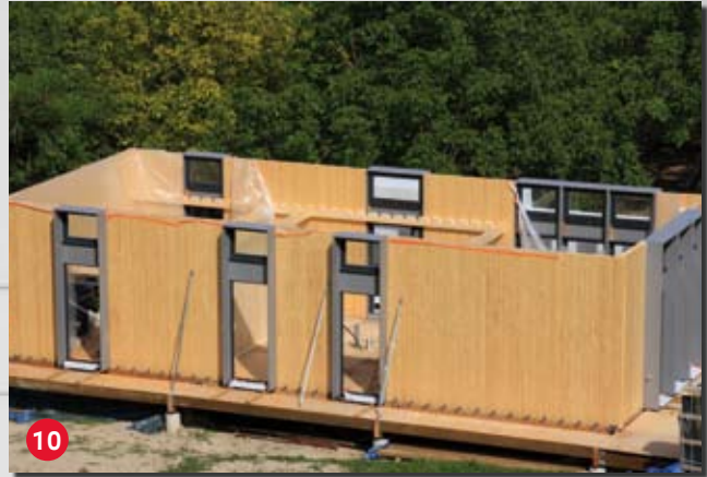
Montage d'un linteau, en bois contrecollé, sur mur porteur, pour accueillir la structure de l'étage. La muralière (poutre dentée) est fixée sur les deux tiers nord de la maison et reçoit les solives du plancher intermédiaire.
