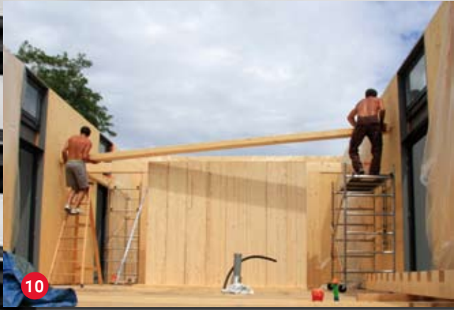
Montage d'un linteau, en bois contrecollé, sur mur porteur, pour accueillir la structure de l'étage. La muralière (poutre dentée) est fixée sur les deux tiers nord de la maison et reçoit les solives du plancher intermédiaire.
