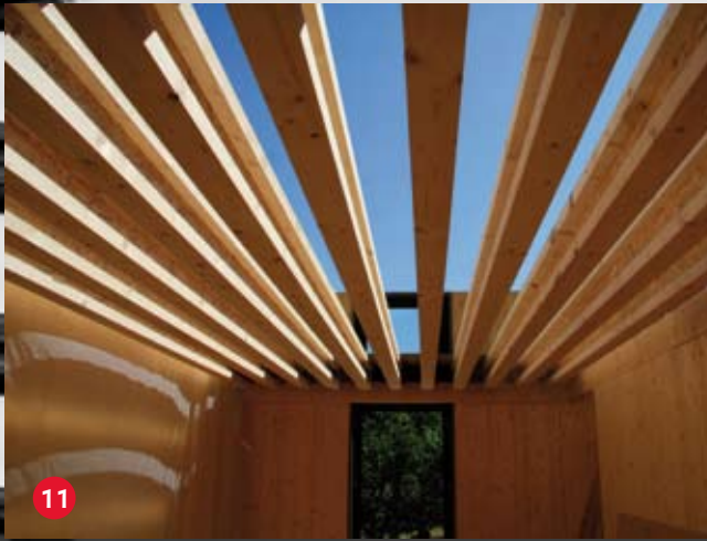
Les poutres en I du plancher intermédiaire sont posées en moins d'une journée.
