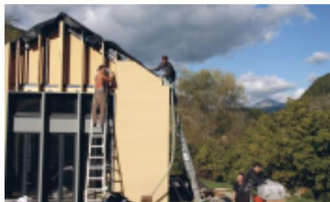
Des panneaux de fibre de bois rigide sont ensuite fixés sur l'ossature secondaire pour fermer des caissons dans lesquels est insufflée la ouate de cellulose en une épaisseur de 300 mm.
