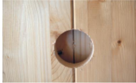
Le système constructif en panneaux de bois massif de 100 mm d'épaisseur permet d'entailer en atelier tous les passages de gaines et d'intégrer les boîtiers d'interrupteurs électriques.
