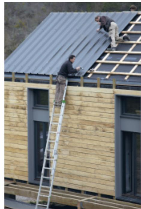
Sur le panneau sandwich isolant, pose du pare-pluie, du lattage et du contrelattage pour recevoir la couverture en bac acier.
