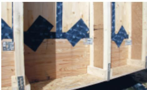
Une ossature secondaire est ensuite assemblée en face extérieure et tous les assemblages sont étanchés par des bandes adhésives pour parfaite l'étanchéité à l'air.
