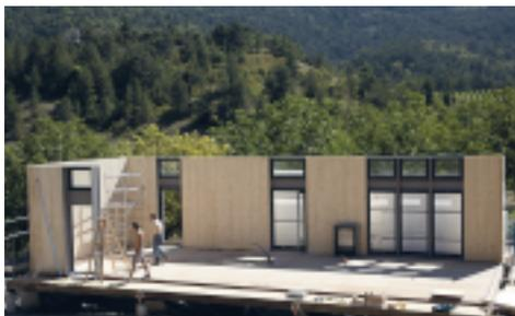
En quelques heures, l'ouvrage prend forme. On remarque que les modules vitrés s'accrochent les uns aux autres comme les pans de murs pleins et que l'ensemble s'arrête au niveau des pannes sablières.
