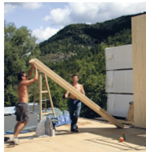
Les murs sont constitués de panneaux de bois massif qui s'assemblent par emboîtement. Le dimensionnement a été calculé pour permettre une manutention à deux personnes, pour se passer d'un engin de levage.
