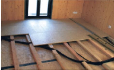
Même aisance pour l'installation des pieuvres électriques dans les planchers.
