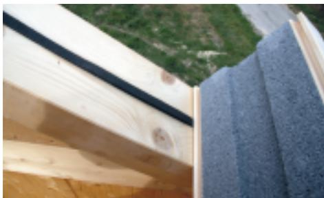
Pour la toiture, les panneaux sandwich font merveille pour leur légèreté d'installation. Autoportants, fournissant le parement en sous-toiture, la dépassée et le fond de clouage pour la couverture, ces panneaux se posent aisément par un néophyte.
