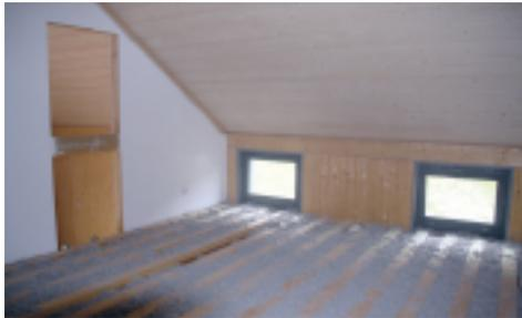
Une épaisse couche de ouate de cellulose vient isoler le plancher intermédiaire. Ainsi s'achève la partie gros-œuvre. Parquets et peintures finiront la demeure.
