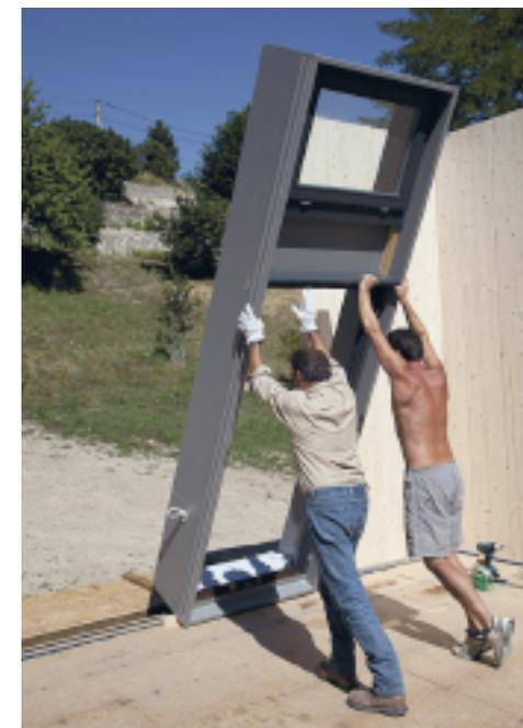
Voici l'un des éléments déterminants qui rend l'autoconstruction accessible à tous : les menuiseries sont constituées de modules complets de même dimension que les pans de murs pleins. Elles s'assemblent, elles aussi par emboîtement à rainure et languette.
