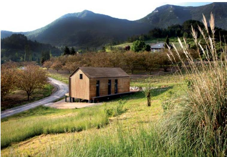
Le système Homelib permet des constructions de 75 à 170 m<sup>2</sup>, avec bardage et couvertures personnalisables.
