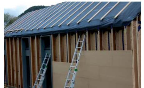
Pose de panneaux de fibre de bois rigides sur les poutres en I verticales, constituant ainsi des caissons dans lesquels la ouate de cellulose sera insufflée.
