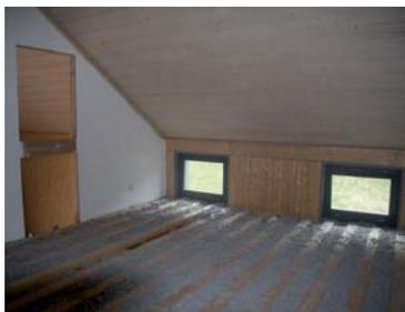
Isolation du plancher de l'étage en ouate de cellulose.
