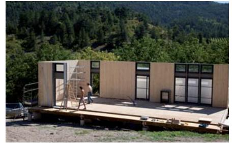
Montage des murs et pré cadres de fenêtres.
