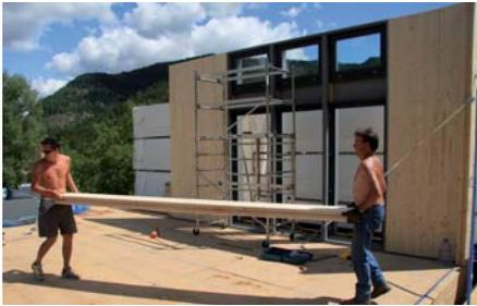
Montage des murs : les panneaux de murs se manipulent aisément à 2 personnes.
