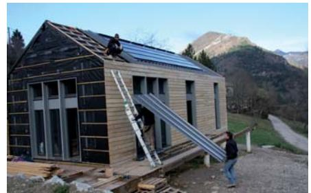
Montage d'une plaque de bac acier. Les plaques se manipulent aisément à 2 personnes.
