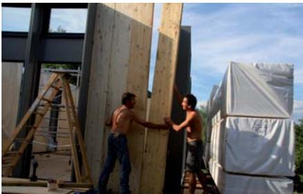
Le montage du dernier élément de mur.
