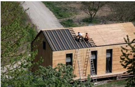
Clouage du bardage en châtaignier sur des lattes en chêne sur le bac acier.
