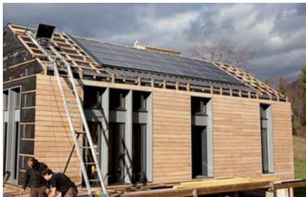
24 modules photovoltaïques sont installés, pouvant générer une production électrique totale de 3 kWc.
