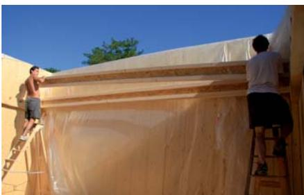
Pose des poutres en I du plancher intermédiaire.
