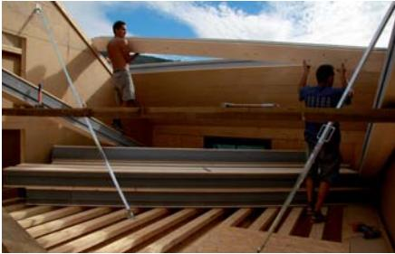
Pose des panneaux de toiture. Ils sont presque tous montés par l'intérieur, ce qui constitue un gain de temps considérable.
