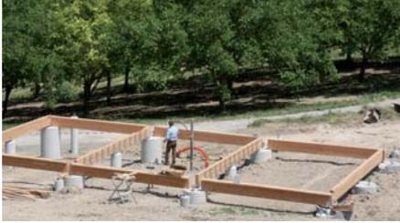
Structure porteuse en bois lamellé-collé sur les plots en béton.
