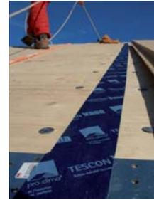
Pose de panneaux d'isolants en fibre de bois rigides, en écran de sous toiture. L'étanchéité à l'air au niveau des liaisons entre panneaux est assurée par ruban adhésif.
