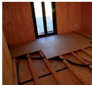
Passage des gaines électriques dans le faux plancher puis pose de panneaux OSB sur les lambourdes.
