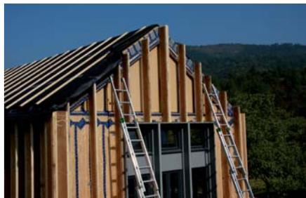
Ossature secondaire : poutres en I verticales qui recevront l'isolation en panneaux de fibre de bois rigides.
