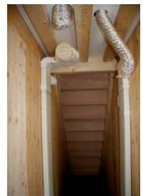
Passage des gaines de VMC dans la cage d'escalier.
